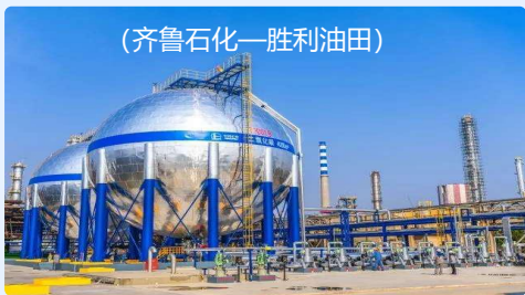
建成国内首条超临界CO 2 输送 管道
